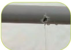
1. Localice la fuga o zona dañada de la tubería a reparar.
