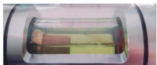
Preencia de humedad
