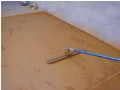
Base capa rodadura y pigmentación. Alisado de la capa de rodadura. Espolvoreo de desmoldeante.
