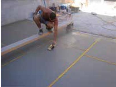
Alisado y extendido del hormigón en fresco. Distribución e introducción de plantillas con la llana.
